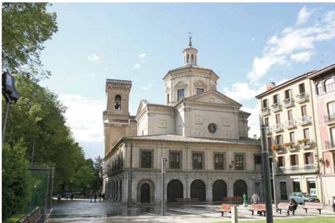
fig. 58.- Capilla de San Fermín. Vista general exterior.
