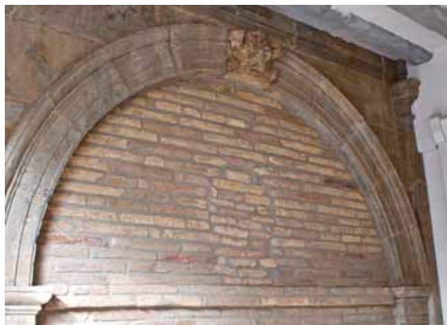
fig. 74.- Arco ciego aparecido en el interior de portal, con huellas de óvalo y ventana rectangular
