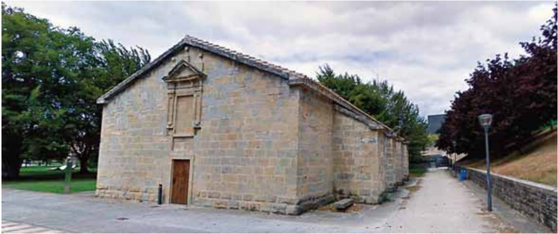
fig. 20.- El polvorín de la Ciudadela de Pamplona en su estado actual
