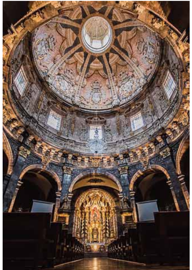
fig. 28.- En Loyola Zaldúa proyectó el apeo de la cúpula mediante una arquería circular a modo de girola
