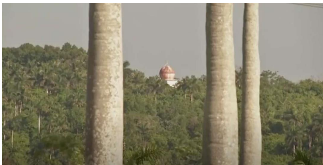
Una de las antenas instaladas en Bejugal
