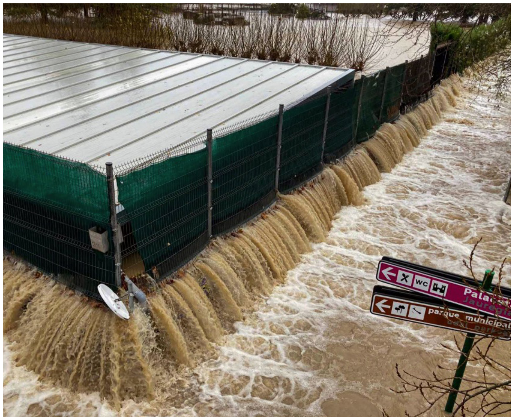
2021 | Recinto de las piscinas municipales de Burlada totalmente inundadas.
