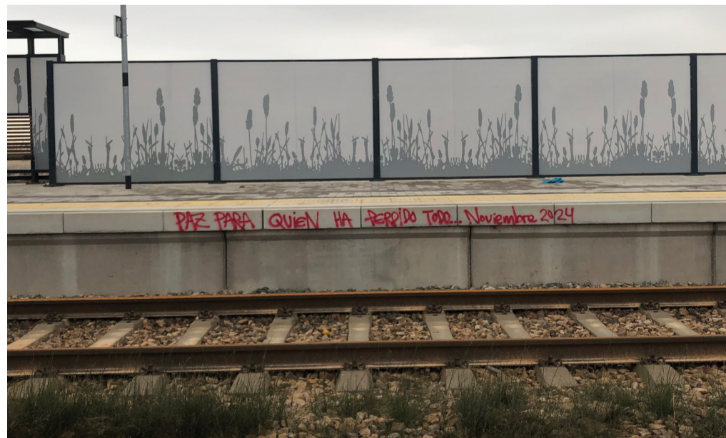
Pintadas en las vías de la estación de cercanías en Albal.
