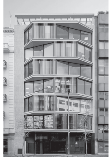
Fig. 7. Estado actual de la fachada del edificio.
