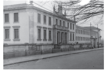
Fig. 3. El Instituto Masculino en construcción. Fachada principal. Manuel Sureda, noviembre de 1947. AGA, Proyecto adicional para el Instituto Nacional de Enseñanza Media de Lugo, Legajo 20437.
