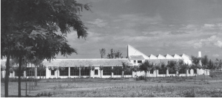
Fig. 5. Alzado al pueblo, con las aulas y los dientes de sierra del salón de actos sobrevalándolas. Joaquín del Palacio, 'Kindel', Archivo de la Fundación Fisac AFF40.
