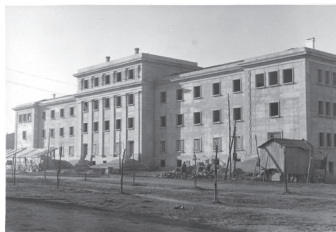
Fig. 4. La Escuela de Magisterio en construcción, 9 de febrero de 1953. Colección del autor.
