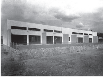
Fig. 4. Imagen actual de una de las clases con las dos aperturas en la pared opuesta al ventanal para facilitar la ventilación cruzada. Directorio propio, octubre de 2023.
